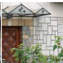
placare de piatră (stânga) și imitație piatră din tencuială (dreapta)
