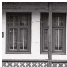
geam simplu - 2 canaturi și supralumină
