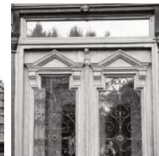
ușă cu supralumină și decorațiuni de lemn și metalice
