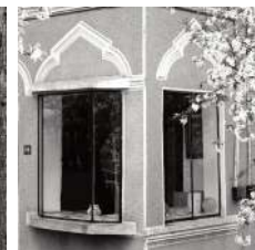
fereastră de colț cu tâmplărie metalică
